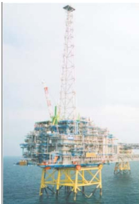
Εικόνα 4.7: Η Πλατφόρμα Sleipner T (T από το treatment = επεξεργασία) στη Βόρεια Θάλασσα χρησιμοποιείται από την Statoil, τη νορβηγική εθνική εταιρεία πετρελαίου, για την απομάκρυνση του CO 2 από φυσικό αέριο κατώτερης ποιότητας
