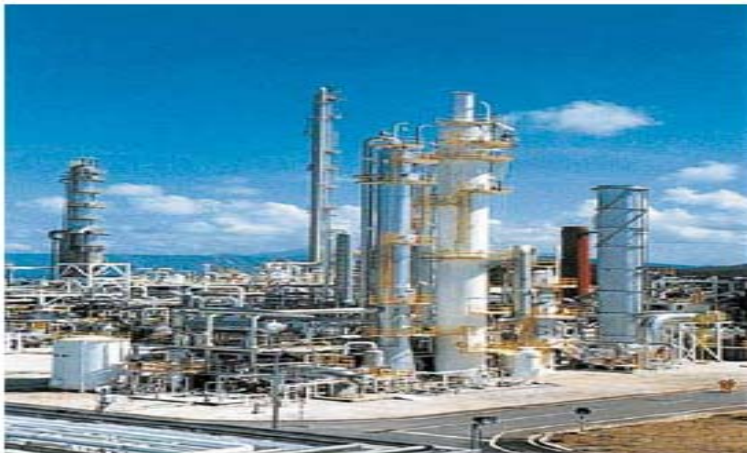
Εικόνα 4.2: Εγκατάσταση διαχωρισμού CO 2 που χρησιμοποιεί τη μέθοδο της χημικής απορρόφησης στη Μαλαισία.
