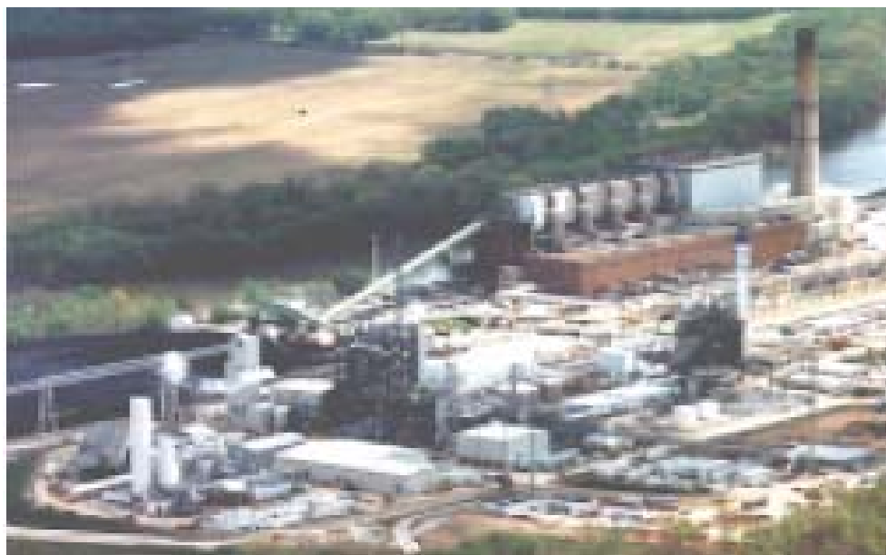
Εικόνα 4.3: Οι εξελιγμένες εγκαταστάσεις παραγωγής ενέργειας με τροφοδότηση ορυκτού άνθρακα, όπως το εργοστάσιο της φωτογραφίας, ένα εργοστάσιο πιλοτικής επίδειξης εξαέρωσης ορυκτού άνθρακα που καίει 800 τόνους την ημέρα, θα έχουν κατά 20 με 35% υψηλότερη αποδοτικότητα μετατροπής της ενέργειας από ότι τα συμβατικά εργοστάσια ατμού κονιορτοποιημένου άνθρακα. Τα εξελιγμένα εργοστάσια ενδείκνυνται πολύ περισσότερο για τη διαχείριση του άνθρακα από ότι τα συμβατικά εργοστάσια.
