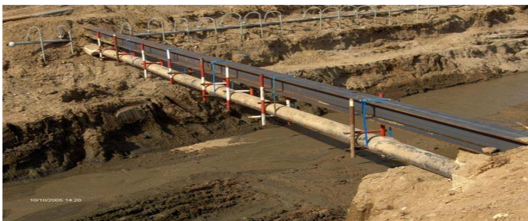
Εικόνα 5.1: Αγωγός μεταφοράς φυσικού αερίου.
