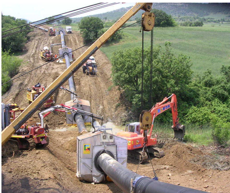
Εικόνα 5.2: Δημιουργία δικτύου σωληνώσεων
