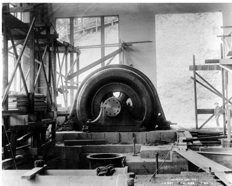
Εικόνα 18: Πρώτη Εγκατάσταση Μηχανής Εσωτερικής Καύσης στο White River Power Plant στη Washington
