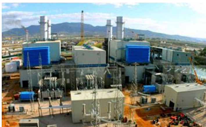
Εικόνα 19: Εργοστάσιο Παραγωγής Ηλεκτρικής Ενέργειας Συνδυασμένου Κύκλου
